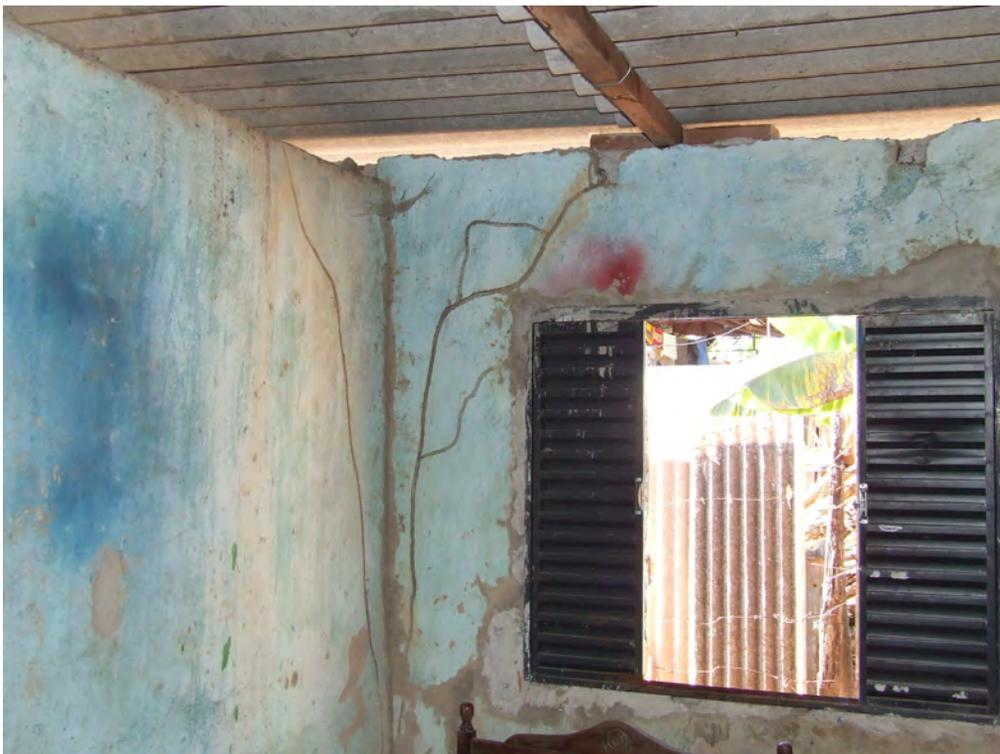
Foto 43 - Vista da pequena inclinação do telhado e paredes sem vigamento e acabamento
