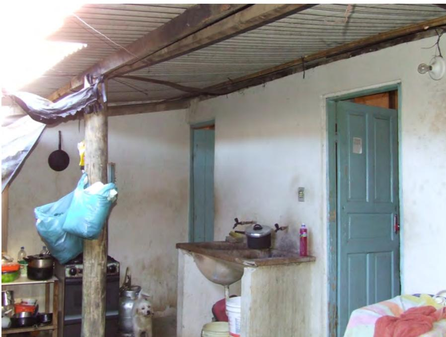
Foto 17 - Vista da estrutura de madeira e telhado da varanda
