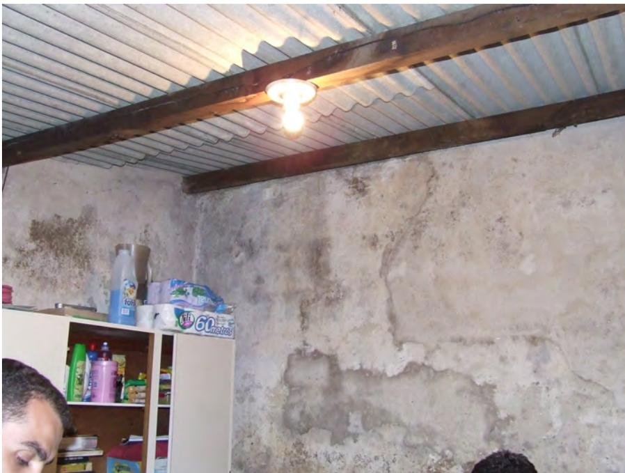
Foto 19 - Vista da parede com infiltração
