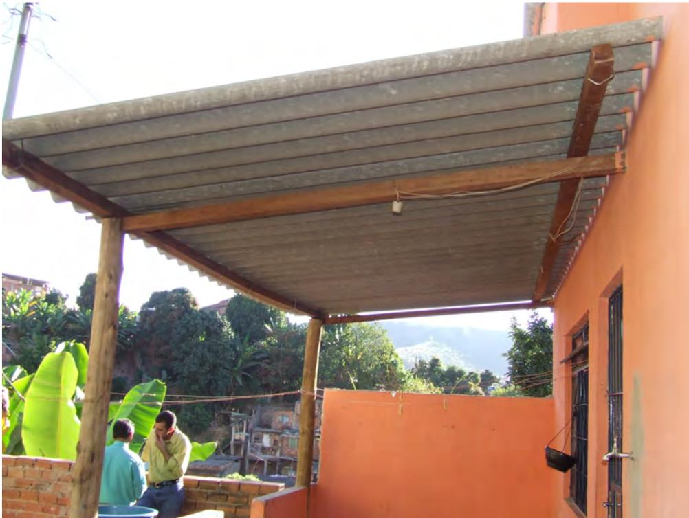
Foto 23 - Vista da estrutura de madeira e telhado da varanda
