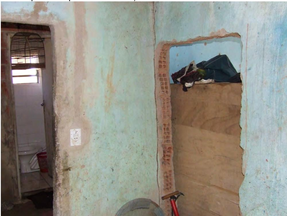
Foto 42 - Vista da demolição da parede conforme projeto, mas falta acabamento
