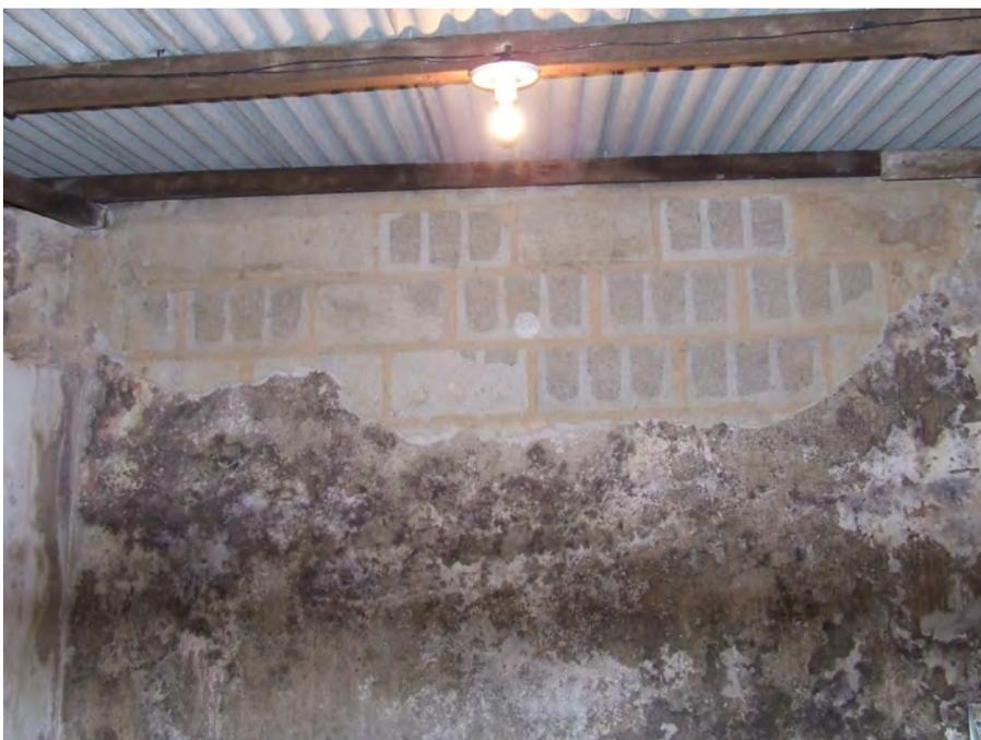
Foto 15 - Vista da parede do quarto com infiltração
