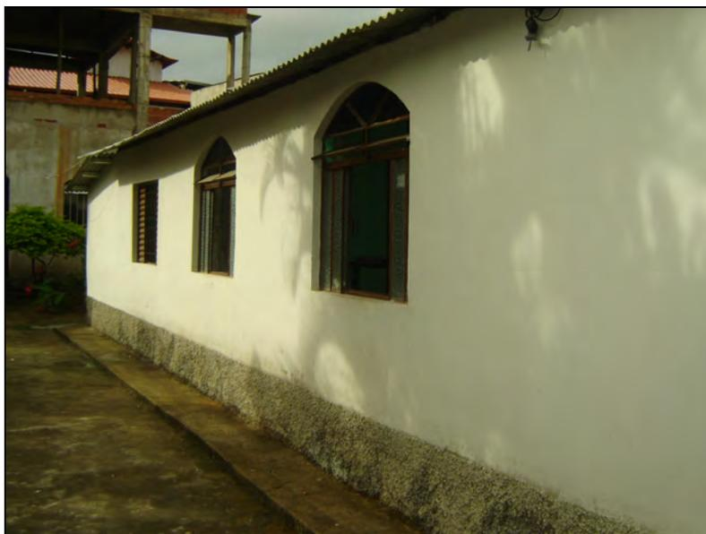
**Foto 16** - Vista da fachada lateral da edificação – notar chapisco e passeio.
