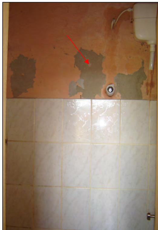
**Foto 41** – Vista da parede do banheiro com tinta látex em degradação.
