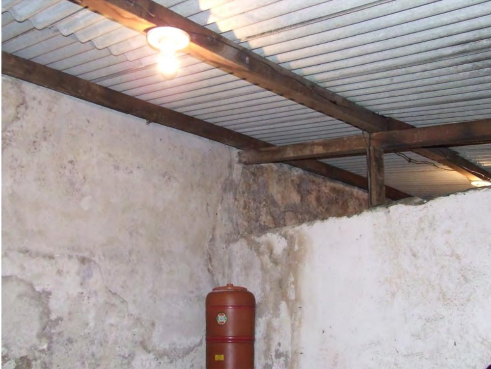
Foto 18 - Vista da parede com infiltração
