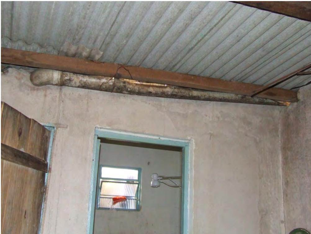
Foto 14 - Vista ampliada do encontro do telhado com a parede(notar falta de rufo e calha, porém não constam na planilha)
