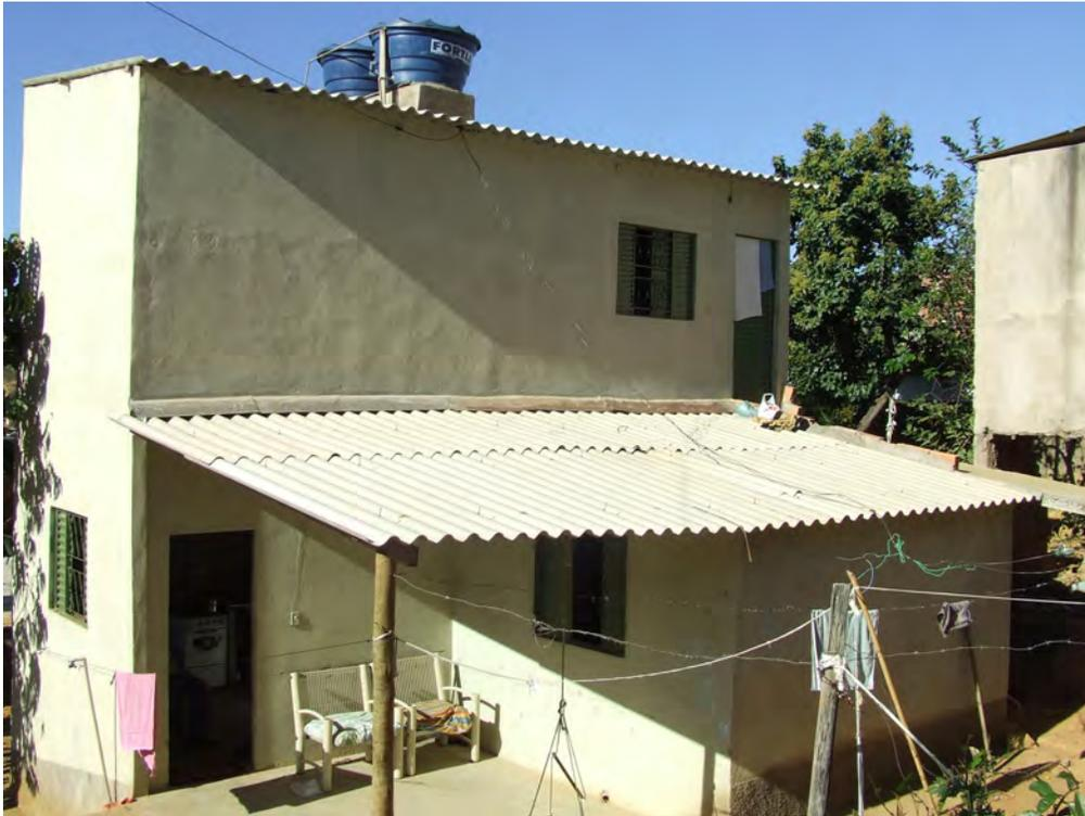
Foto 10 - Vista lateral da residência(notar telhado, reservatório, peça de eucalipto e janela de metalon)
