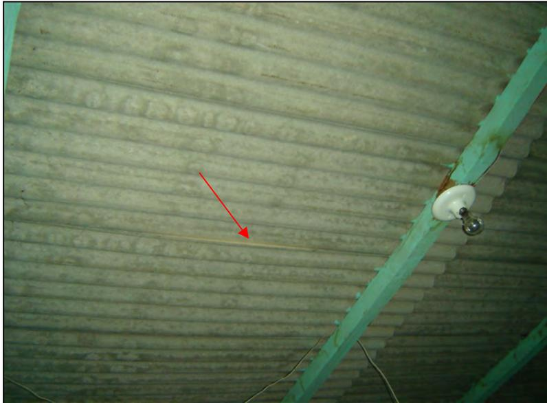
**Foto 21** - Vista do telhado – notar problema de encaixe das telhas.
