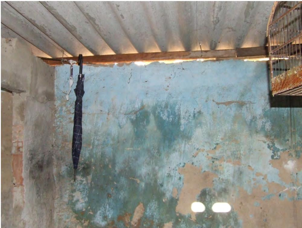
Foto 37 - Vista do telhado(notar falta de acabamento)
