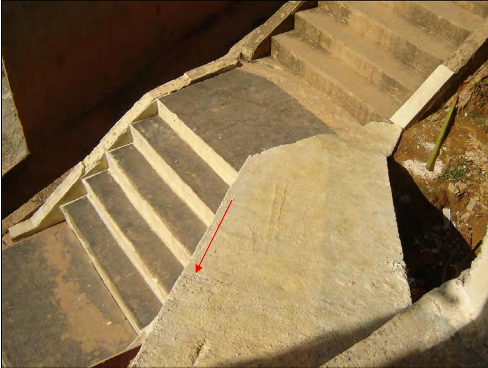
**Foto 36** – Escada e rampa de acesso necessitariam de guarda corpo não previsto em projeto.
