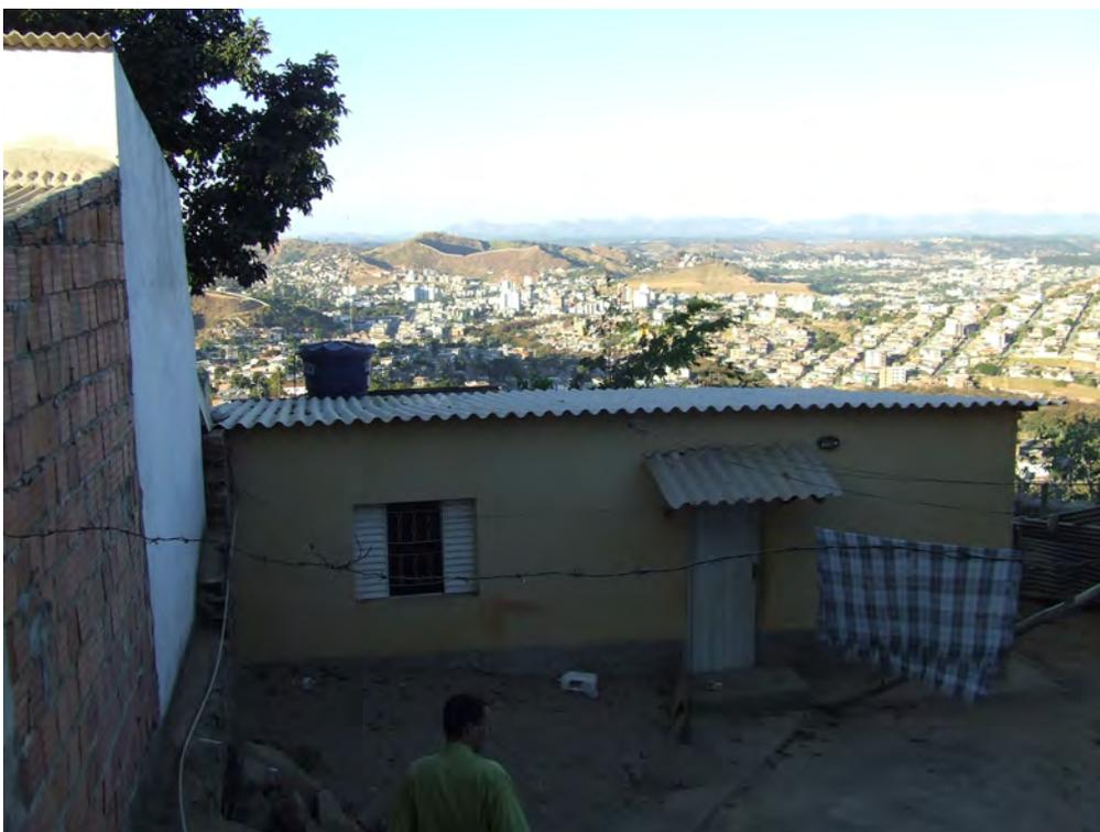
Foto 27 - Vista frontal da residência (notar telhado, reservatório, janela metálica e chapisco no barrado)
