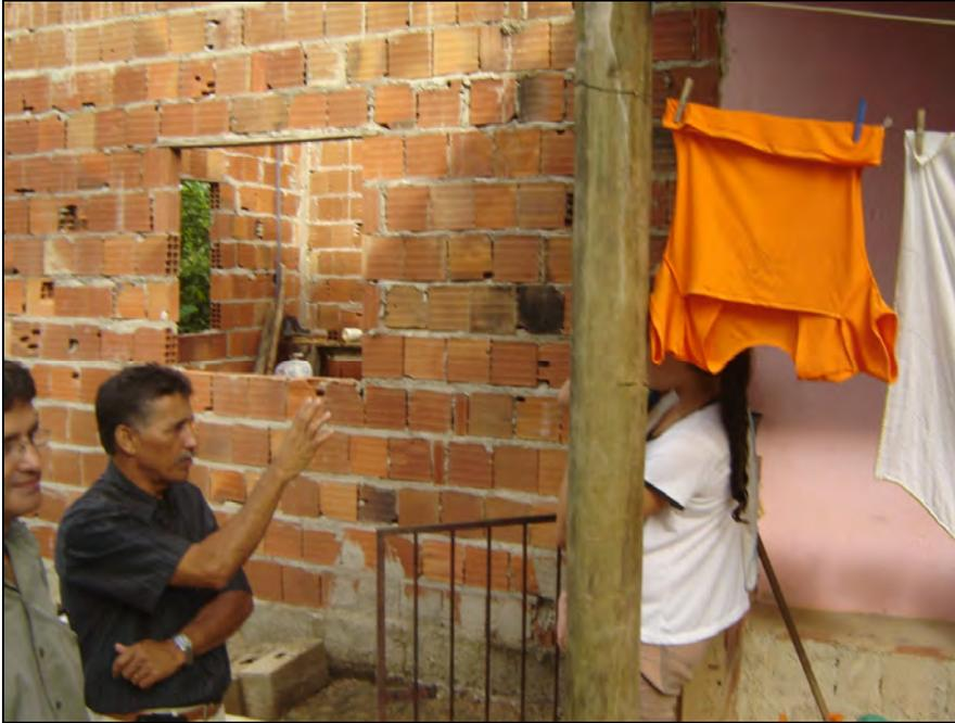
**Foto 26** - Vista da ampliação executada pelo morador – em obras.
