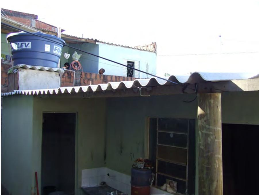
Foto 02 - Vista do telhado(notar caixa d'água e pilar de eucalipto)
