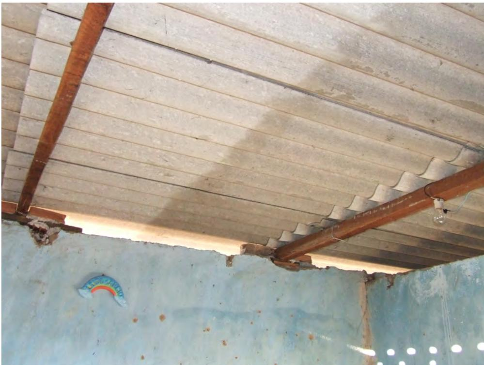
Foto 39 - Vista da parede que apóia o telhado sem vigamento. Alvenaria e revestimento incompleto).
