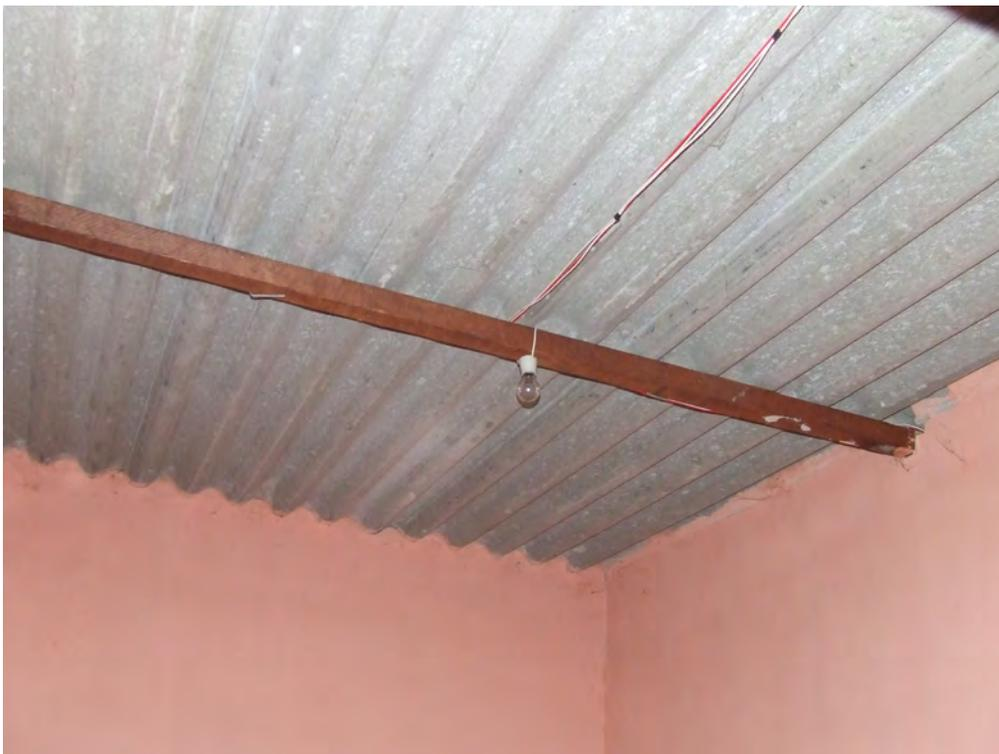
Foto 21 - Vista da estrutura de madeira e fiação aparente
