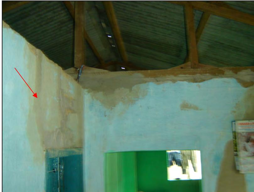
**Foto 17** - Vista interna do telhado – notar recuperação de trincas – Pintura interna não era objeto da planilha de obras.
