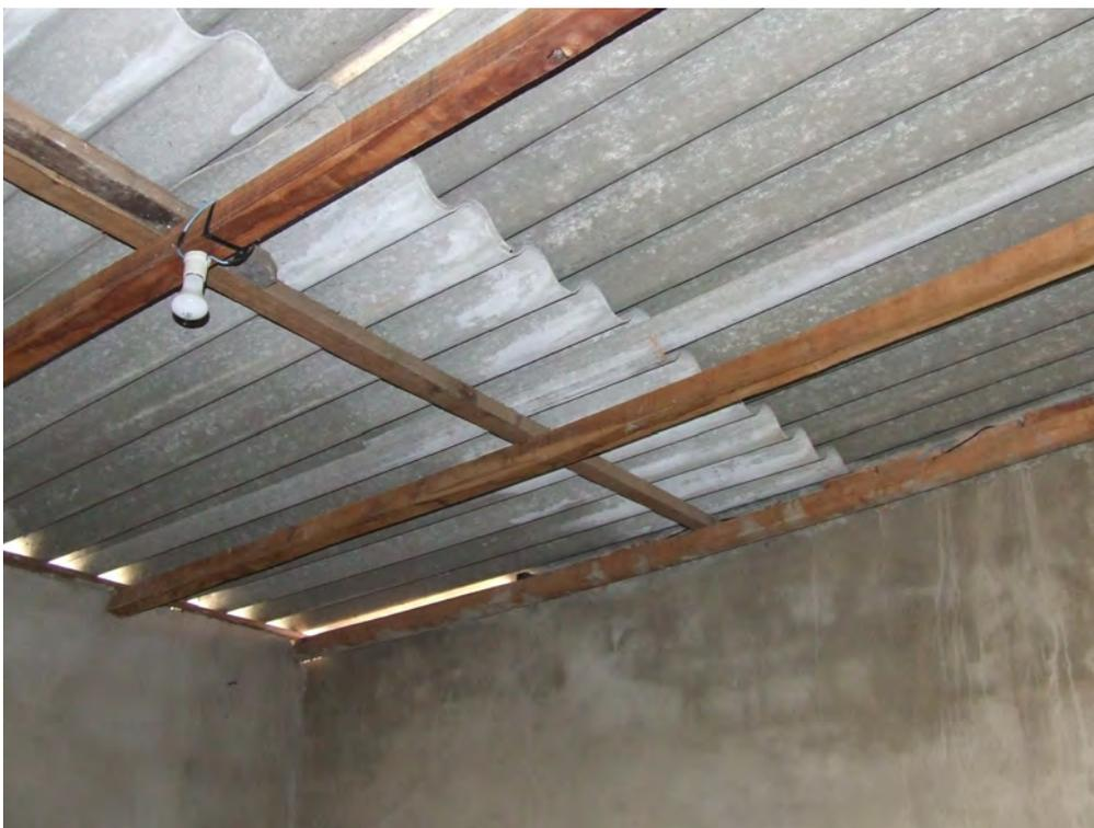
Foto 33 - Vista da estrutura de madeira e telhado (notar falta do rufo)
