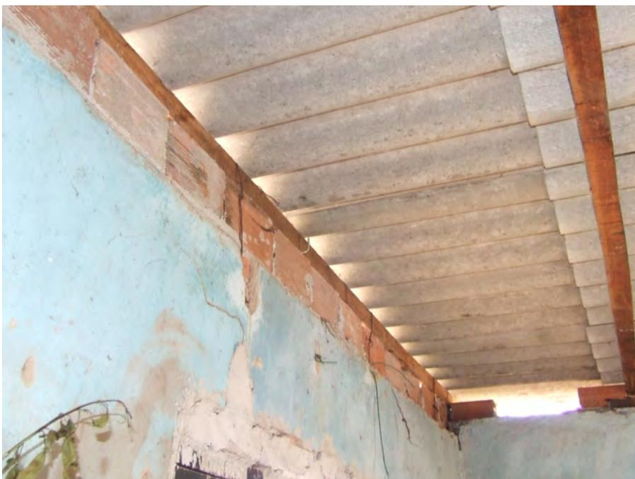
Foto 40 - Vista da falta de acabamento das paredes que apóiam o telhado
