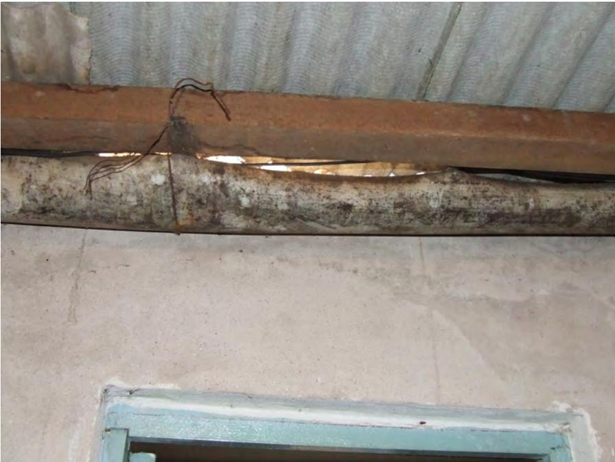
Foto 13 - Vista do encontro do telhado com a parede(notar falta de rufo e calha, porém não constam na planilha)
