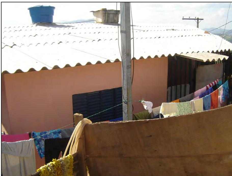
**Foto 38** – Vista externa da edificação – notar telhado, banheiro e reservatório.
