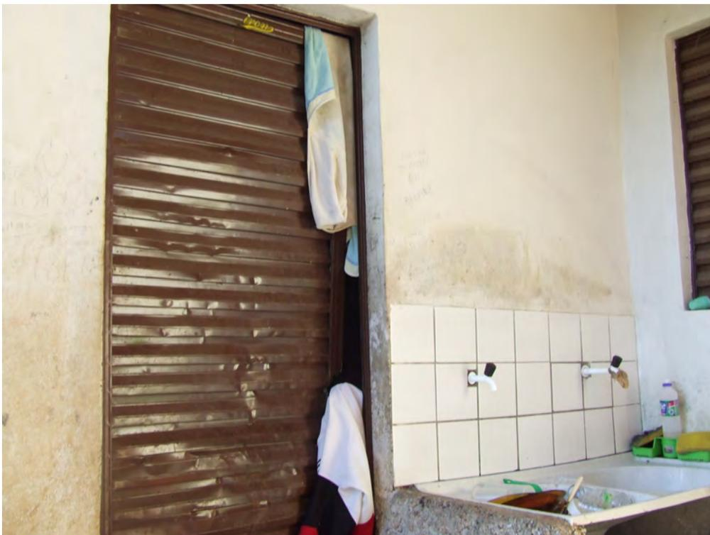
Foto 54 - Vista do tanque e porta de metalon(notar porta danificada)
