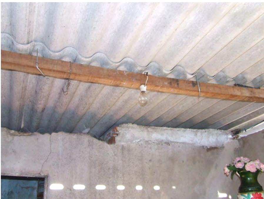
Foto 38 - Vista da estrutura de madeira e telhado(notar falta de acabamento)
