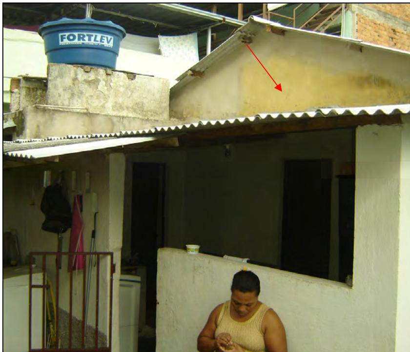
**Foto 18** - Fundos da edificação – notar falta de pintura na empena do telhado.
