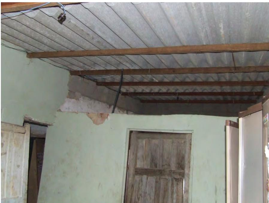
Foto 06 - Vista da estrutura de madeira e das telhas(notar falta de acabamento nas paredes)
