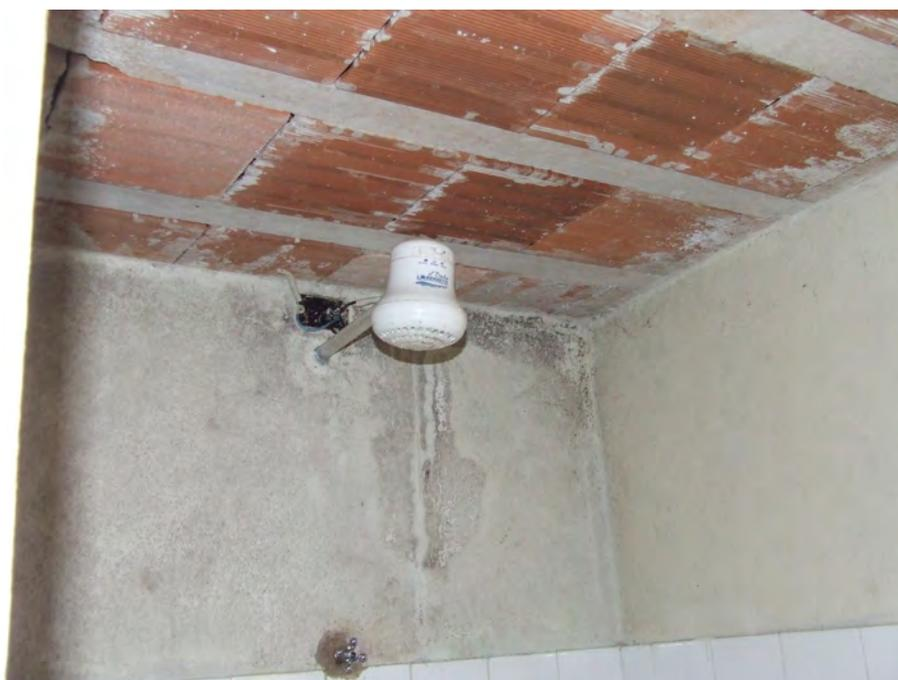
Foto 44 - Vista da parede do banheiro com infiltração
