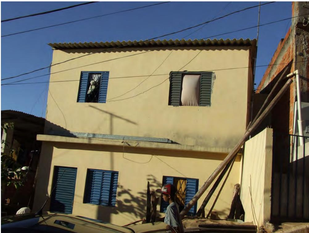
Foto 24 - Vista frontal da residência (pavimento superior – notar fachada rebocada com janelas de metalon, porta em gradil e telhado novo)
