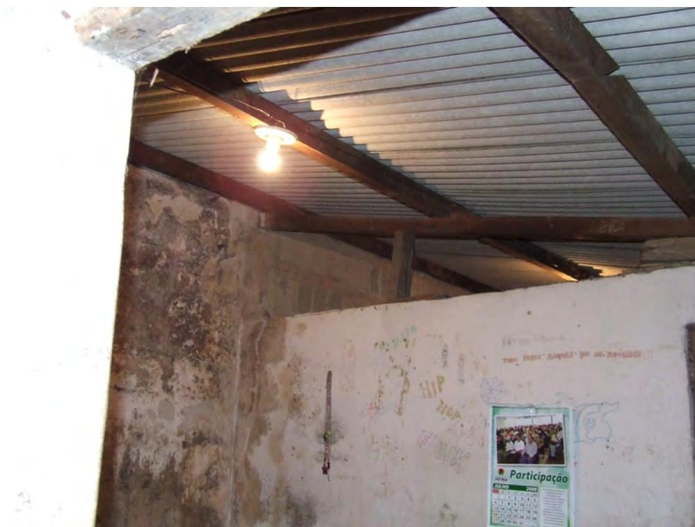
Foto 11 - Vista da estrutura de madeira e telhado(notar infiltração na parede)
