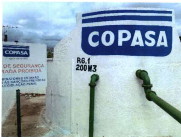
Figura 235 - Estrutura do reservatório RAP-6.1
