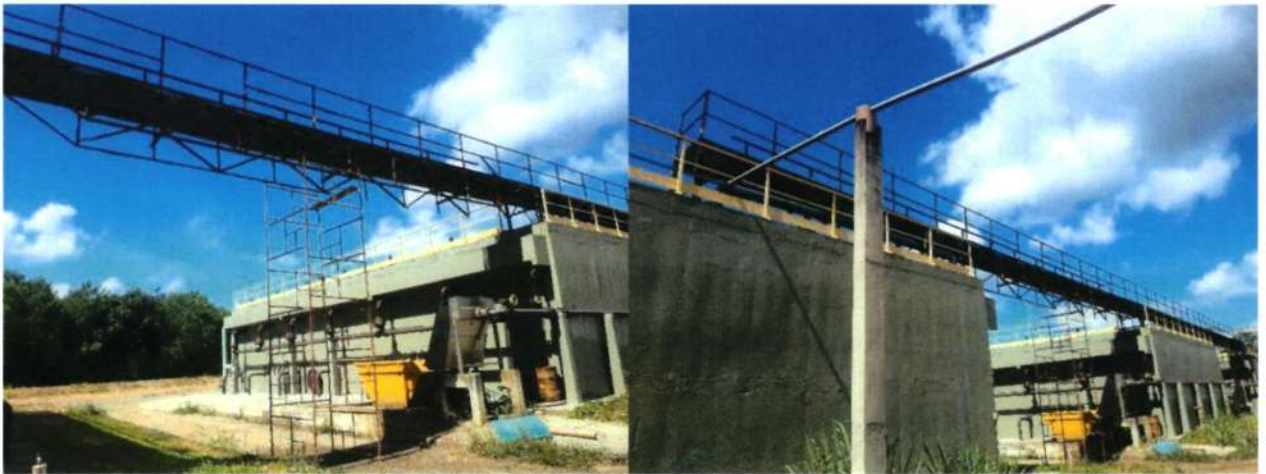
Figura 23 – Guarda-corpo e Passarelas metálicas.
