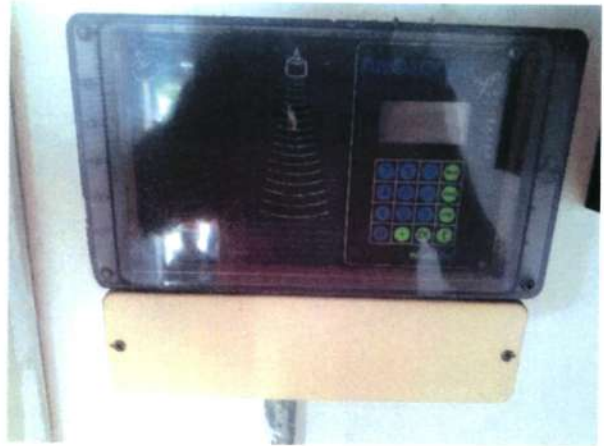
Figura 309 - Censor de nível EEE Novo Centro
