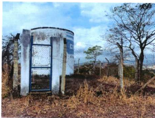
Figura 240 - Acesso reservatório RAP-6.3
