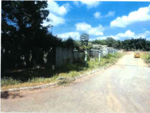
Figura 366 – Filtros biológicos ETE Ipanema
