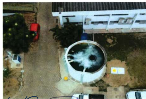
Figura 55 - Local de chegada de água bruta
