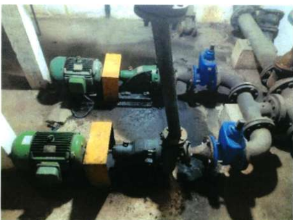
Figura 105 - Estrutura Hidromecânica do Booster
