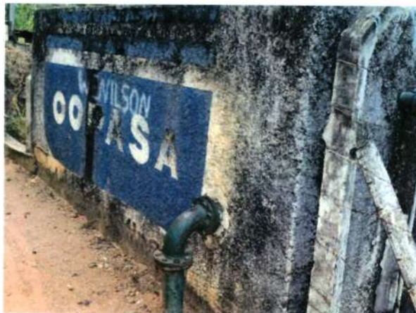
Figura 275 - Estrutura do reservatório RAP-3.4
