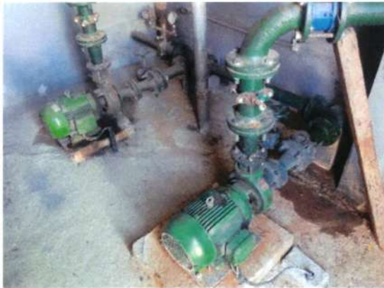
Figura 98 – Estrutura hidromecânica do Booster
