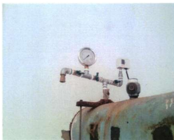
Figura 141 - Manômetro e Pressostato do Booster
