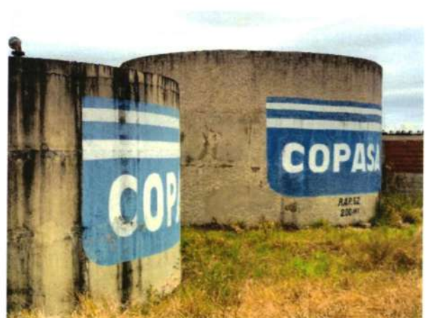
Figura 264 - Estrutura do reservatório RAP-5.2 e RAP-5.2A
