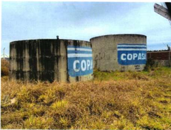
Figura 263 - Estrutura do reservatório RAP-5.2 e RAP-5.2A
