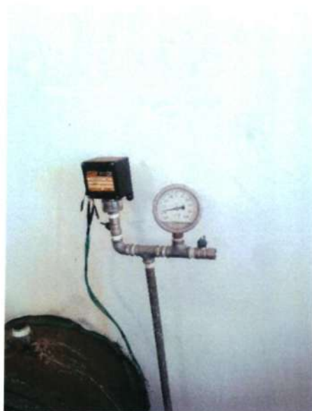
Figura 162 – Manômetro e Pressostato de entrada EAT-6 e EAT-6.1
