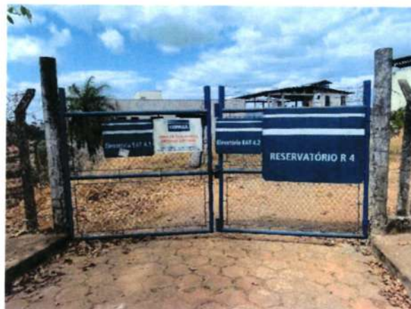
Figura 211 - Acesso reservatório R-4
