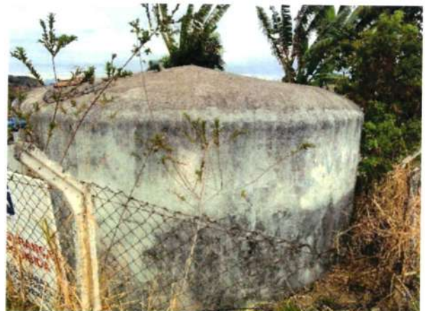
Figura 267 - Estrutura do reservatório RAP-6.4
