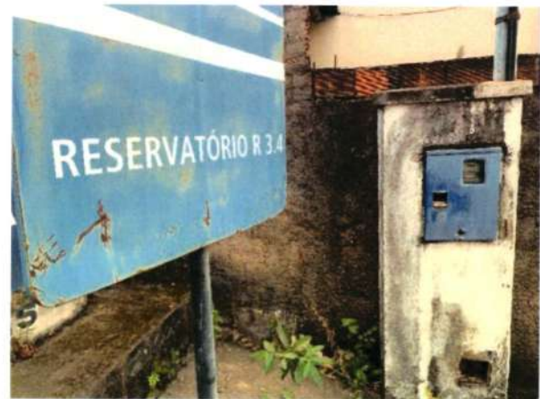
Figura 273 - Acesso reservatório RAP-3.4
