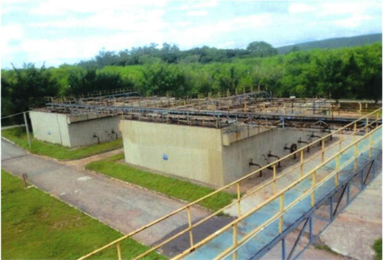
Figura 22 – Reatores UASB – Elaboração do PMSB de Ipatinga – MG.
