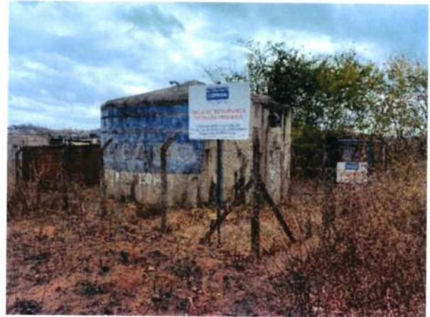
Figura 224 - Acesso reservatório R-5.1
