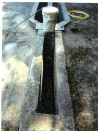
Figura 321 - Gradeamento de entrada do esgoto bruto ETE Areal
