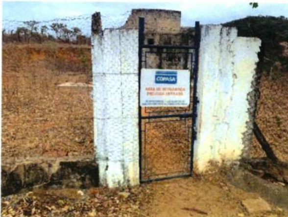
Figura 254 - Acesso reservatório RAP-2.4
