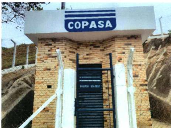
Figura 112 - Estrutura da elevatória
