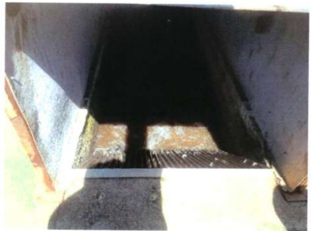
Figura 357 - Gradeamento da entrada de esgoto bruto ETE Ipanema
