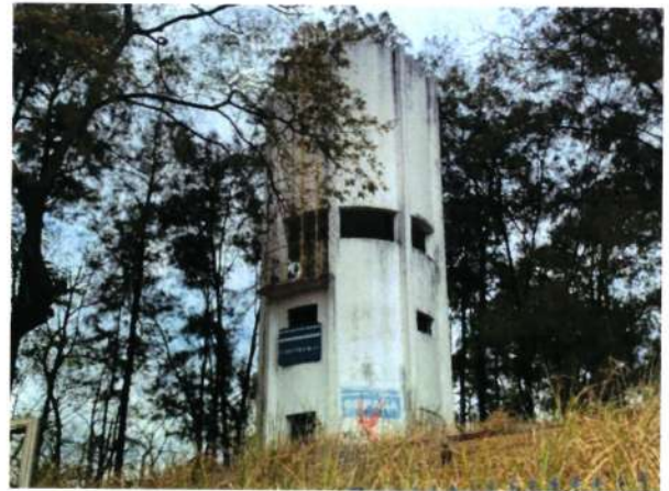
Figura 270 - Estrutura do reservatório REL-1.1A
