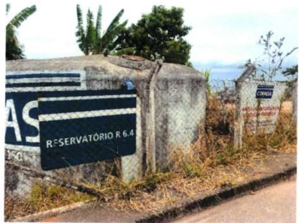
Figura 265 - Acesso reservatório RAP-6.4
