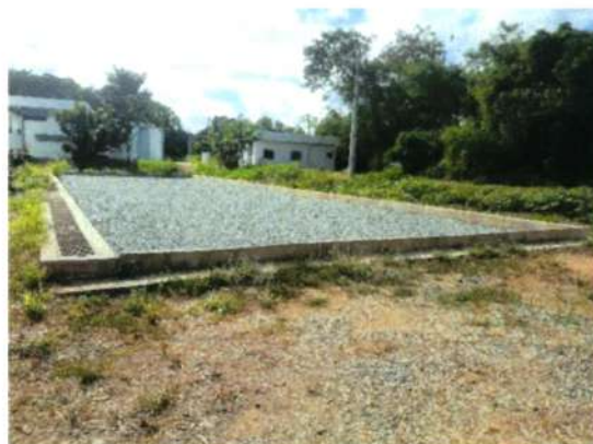
Figura 67 – Base para depósito de BAGs de lodo desidratado
