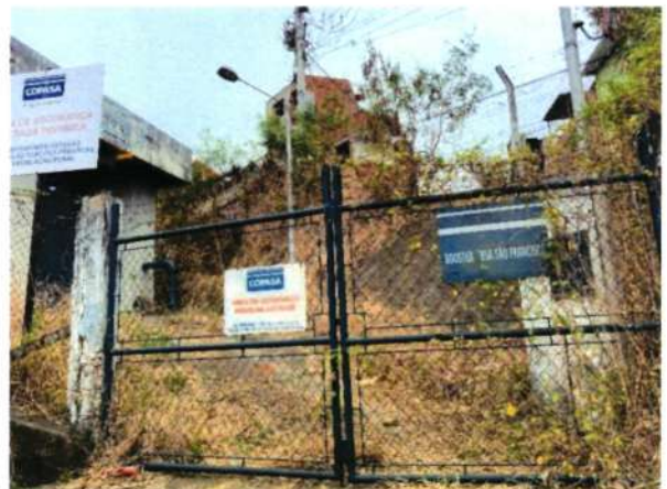
Figura 118 - Booster Morro São Francisco
