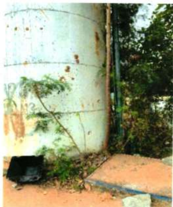
Figura 246 - Estrutura do reservatório RAP-6.5
