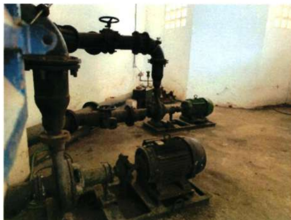
Figura 123 - Equipamentos Booster Nova Esperança
