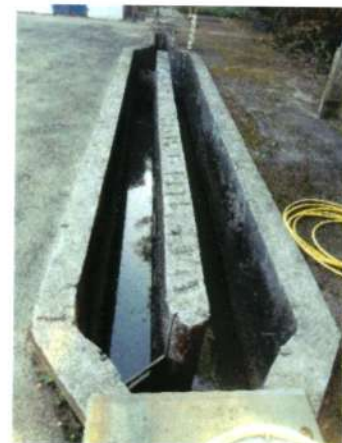
Figura 322 - Entrada do esgoto bruto ETE Areal
