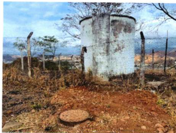
Figura 242 - Estrutura do reservatório RAP-6.3
