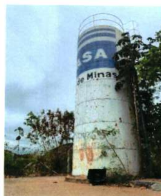
Figura 245 - Estrutura do reservatório RAP-6.5
