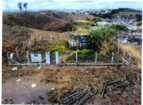
Figura 259 - Acesso reservatório RAP-4.4
