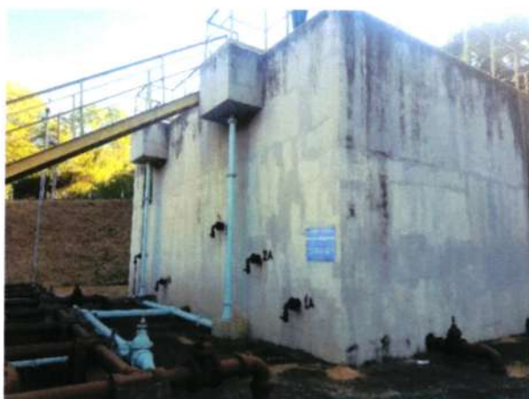
Figura 336 – Leito de secagem de lodo ETE Bela Vista
