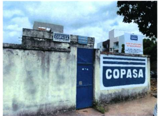
Figura 124 - Booster Parque das Águas
