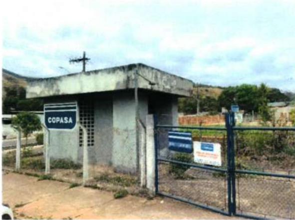
Figura 116 - Acesso do Booster Morro Cruzeiro
