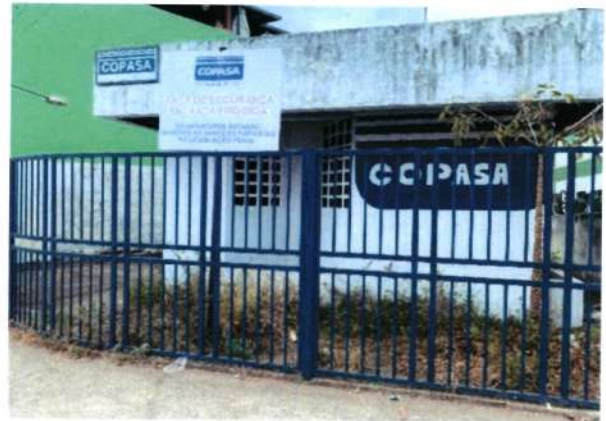
Figura 217 - Acesso reservatório RAP-4.3
