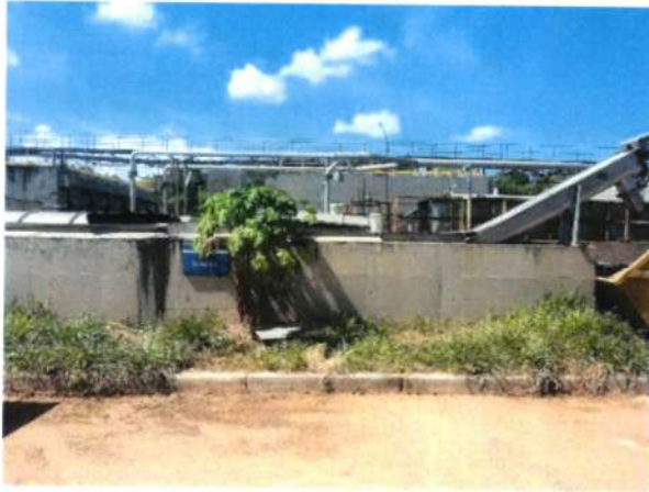
Figura 360 – Desarenador ETE Ipanema
