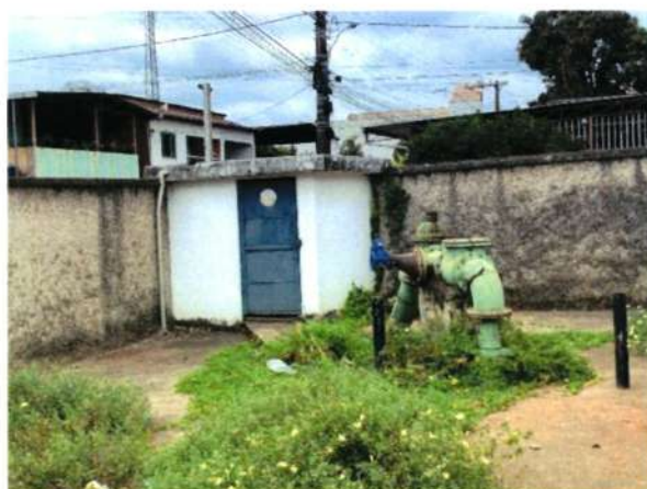
Figura 37 - Estrutura física da captação
