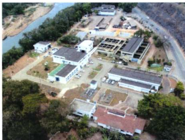
Figura 51 - Imagem área da ETA
