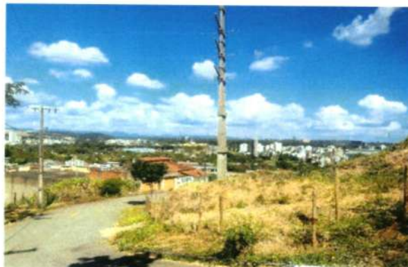
Figura 223 - Acesso Reservatório R-5
