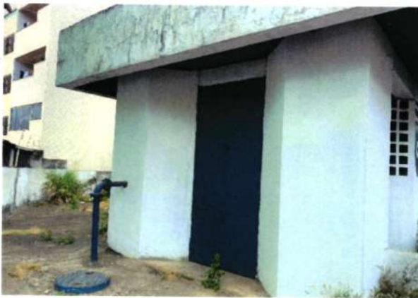
Figura 218 - Estrutura do reservatório RAP-4.3
