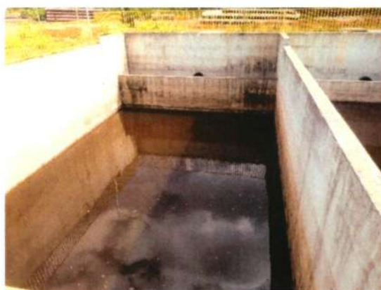
Figura 65 – Tanque para desidratação de lodo
