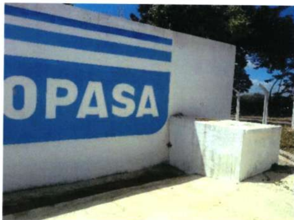
Figura 203 - Estrutura reservatório RAP-2.2
