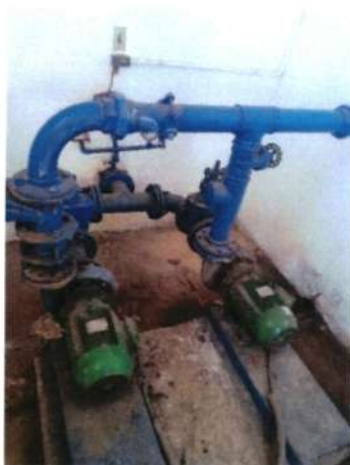
Figura 145 - Estrutura Hidromecânica do Booster
