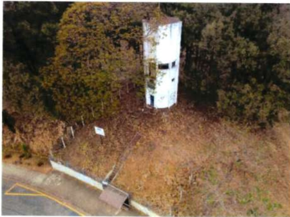
Figura 269 - Estrutura do reservatório REL-1.1A
