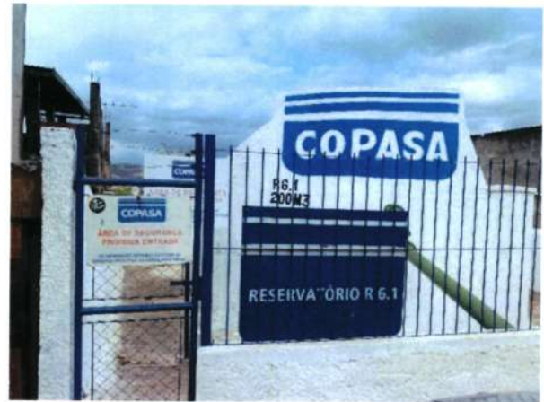
Figura 234 - Acesso reservatório RAP-6.1
