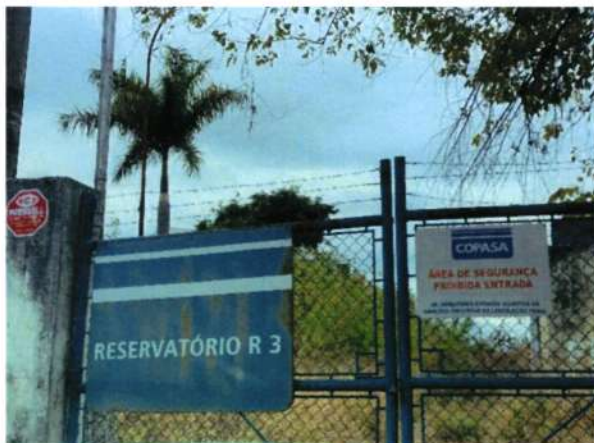
Figura 206 - Identificação reservatório R-3
