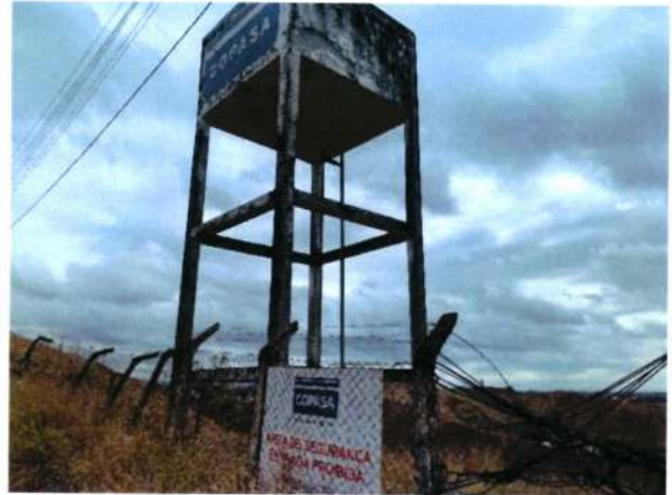
Figura 214 - Acesso reservatório REL-4.1
