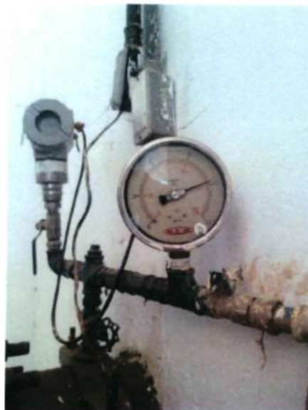
Figura 163 - Manômetro e Pressostato de saída EAT-6 e EAT-6.1
