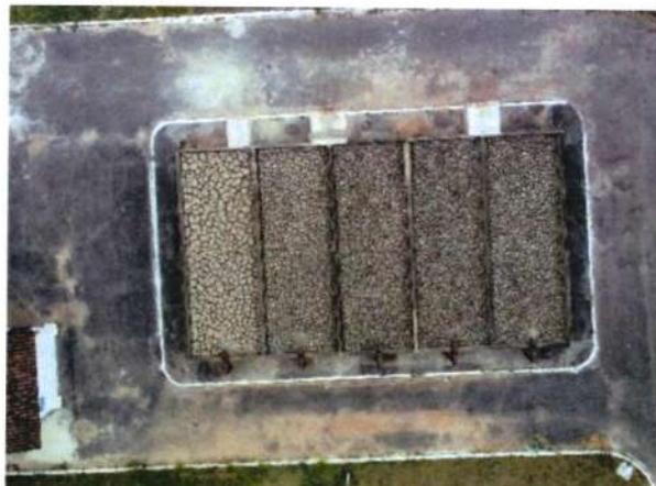
Figura 315 - Leito de secagem ETE Areal
