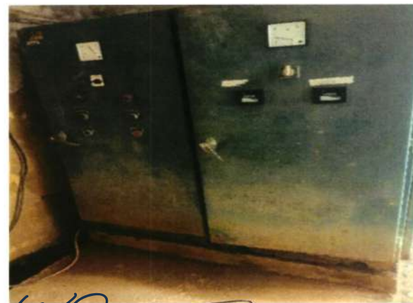
Figura 90 – Painel de comando do Booster
