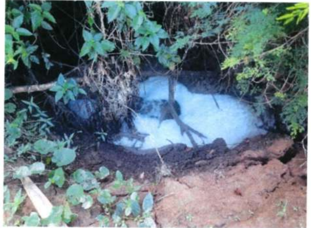
Figura 350 – Lançamento final do esgoto tratado ETE Horto
