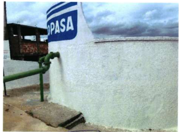
Figura 236 - Estrutura do reservatório RAP-6.1
