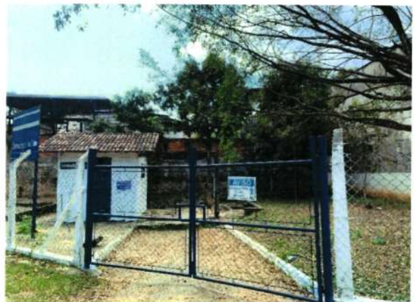
Figura 301 - Acesso EEE Novo Centro
