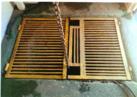
Figura 311 – Poço de sucção EEE Vila da Paz
