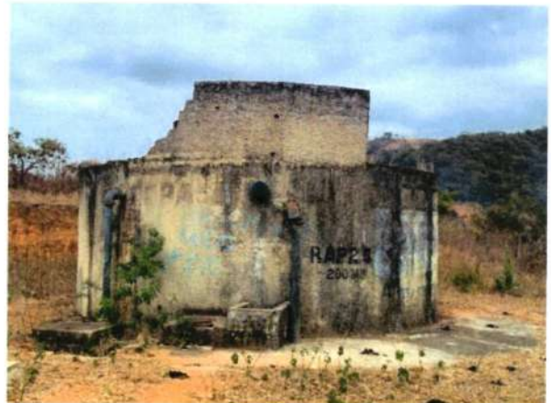
Figura 255 - Estrutura do reservatório RAP-2.4
