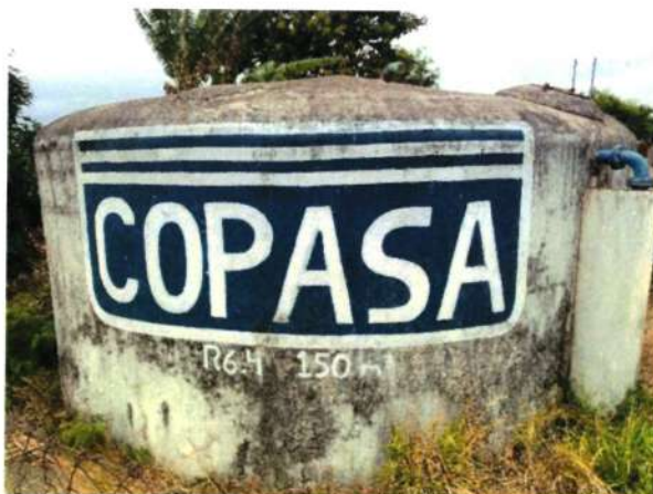
Figura 266 - Estrutura do reservatório RAP-6.4
