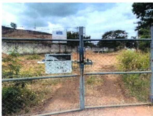
Figura 35 - Portão de acesso aos poços
