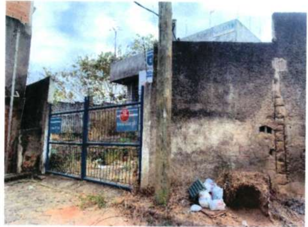
Figura 229 - Acesso reservatório RAP-6
