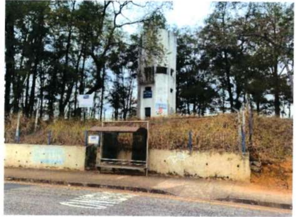
Figura 268 - Acesso reservatório REL-1.1A
