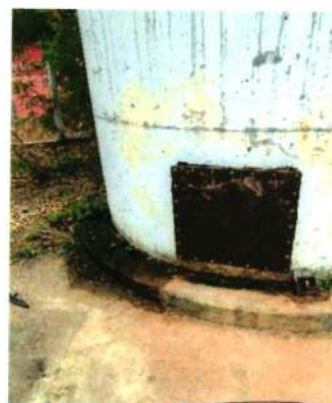
Figura 247 - Estrutura do reservatório RAP-6.5
