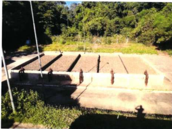
Figura 325 – Leito de secagem de lodo ETE Areal
