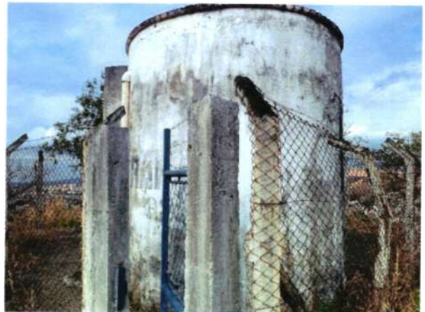
Figura 239 - Estrutura do reservatório RAP-6.2
