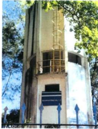
Figura 271 - Estrutura do reservatório REL-1.1A
