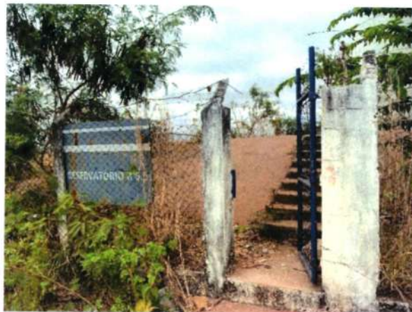
Figura 243 - Acesso reservatório RAP-6.5
