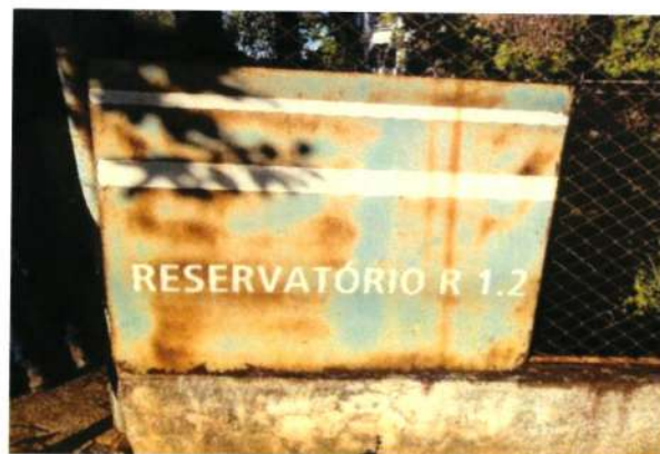
Figura 193 – Identificação reservatório RAP-1.2
