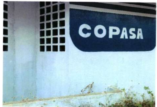
Figura 219 - Estrutura do reservatório RAP-4.3
