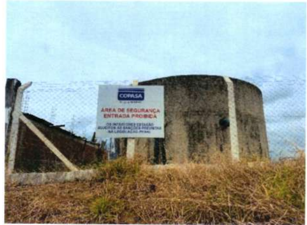
Figura 262 - Acesso reservatório RAP-5.2 e RAP-5.2A
