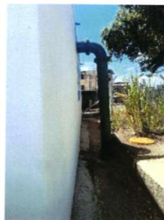
Figura 204 - Estrutura reservatório RAP-2.2
