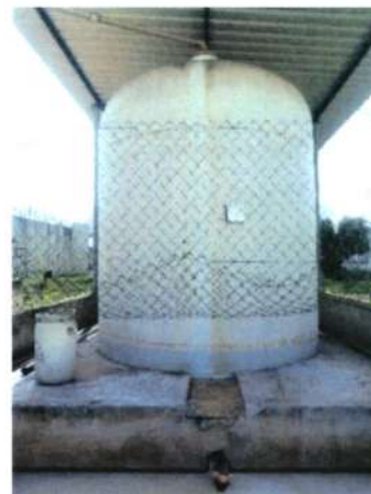
Figura 65 – Tanque para desidratação de lodo
