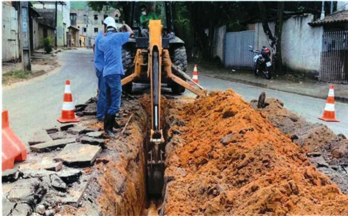
Figura 20 - Obras sendo executadas no setor Bucaina
