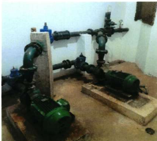
Figura 84 – Estrutura Hidromecânica do Booster
