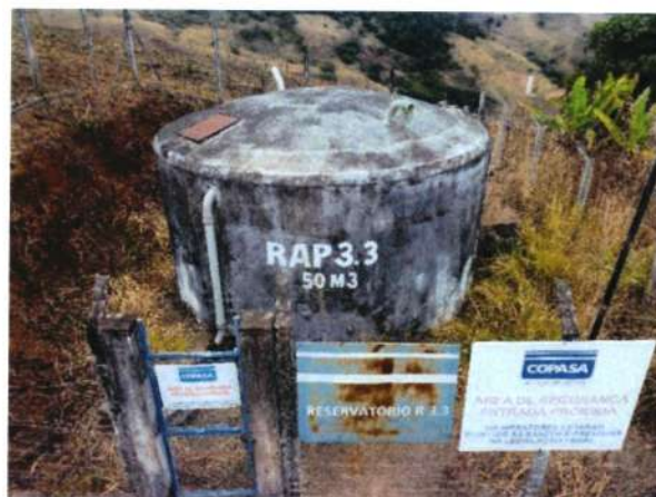
Figura 256 - Acesso reservatório RAP-3.3
