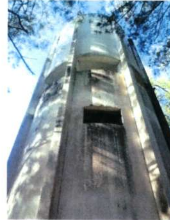
Figura 272 - Estrutura do reservatório REL-1.1A
