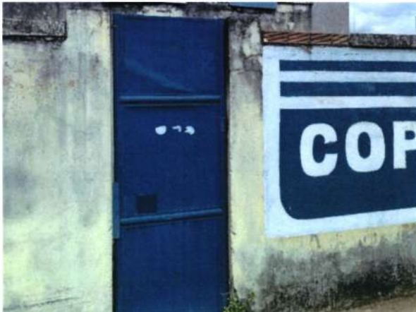
Figura 125 - Booster Parque das Águas
