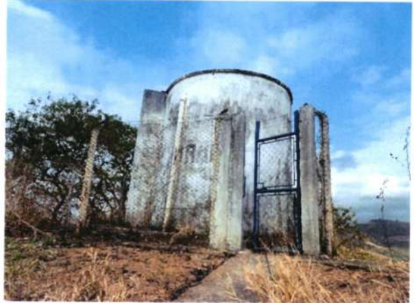
Figura 237 - Acesso reservatório RAP-6.2
