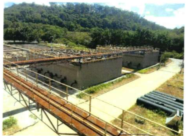
Figura 365 – Reatores UASB ETE Ipanema
