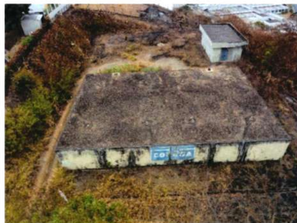
Figura 207 - Imagem superior reservatório R-3
