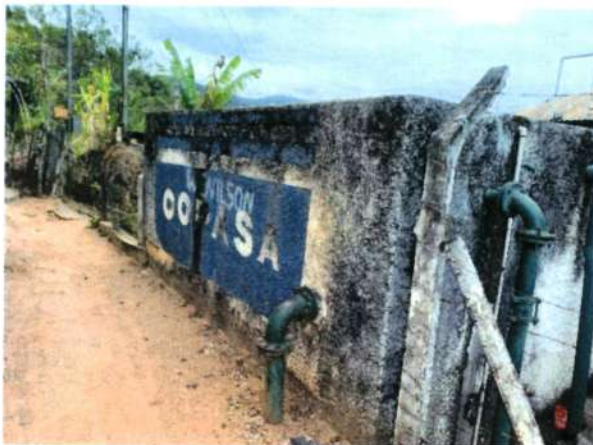
Figura 274 - Estrutura do reservatório RAP-3.4
