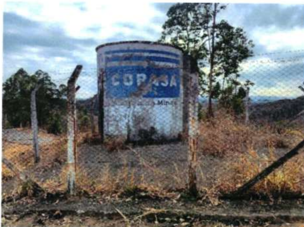
Figura 238 - Estrutura do reservatório RAP-6.2
