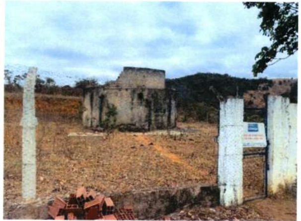
Figura 253 - Acesso reservatório RAP-2.4
