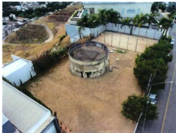
Figura 208 - Imagem superior do reservatório RAP-3.1
