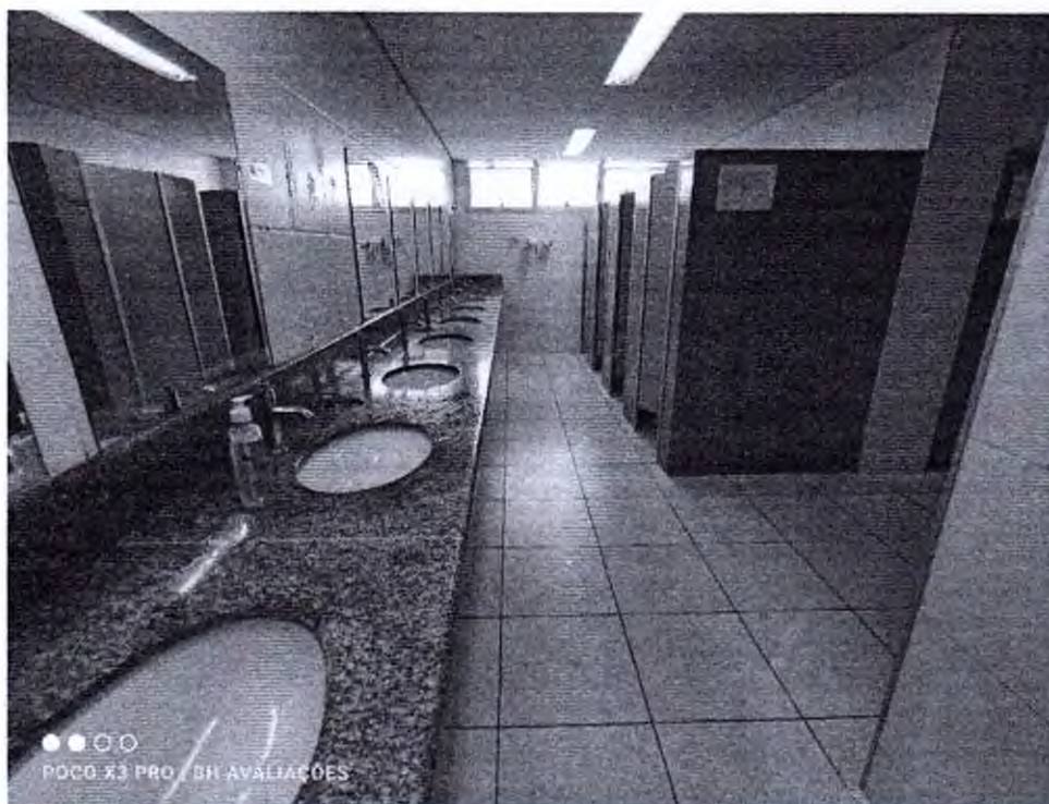
Instalação sanitária no pavimento térreo.
