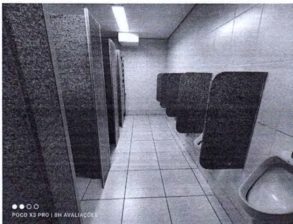
Instalação sanitária no pavimento térreo.
