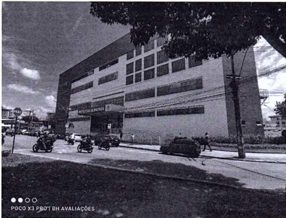
Fachada voltada para a Avenida Carlos Chagas nº 789, Bairro Cidade Nobre, Ipatinga/MG.
