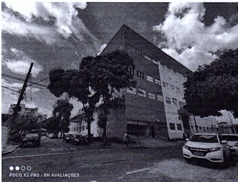
Fachadas voltadas para as Ruas Canudos e Gonçalves Dias, Bairro Cidade Nobre, Ipatinga/MG.
