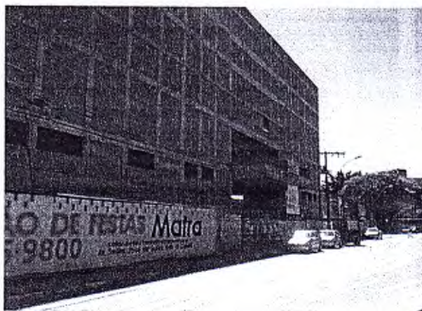
Tomada da Rua Gonçalves Dias, sentido Avenida Simon Bolivar.
