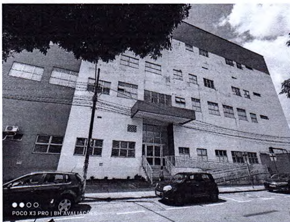
Fachada voltada para a Rua Gonçalves Dias, Bairro Cidade Nobre, Ipatinga/MG.
