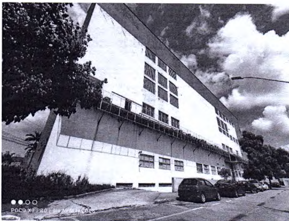
Fachada voltada para a Rua Canudos, Bairro Cidade Nobre, Ipatinga/MG.
