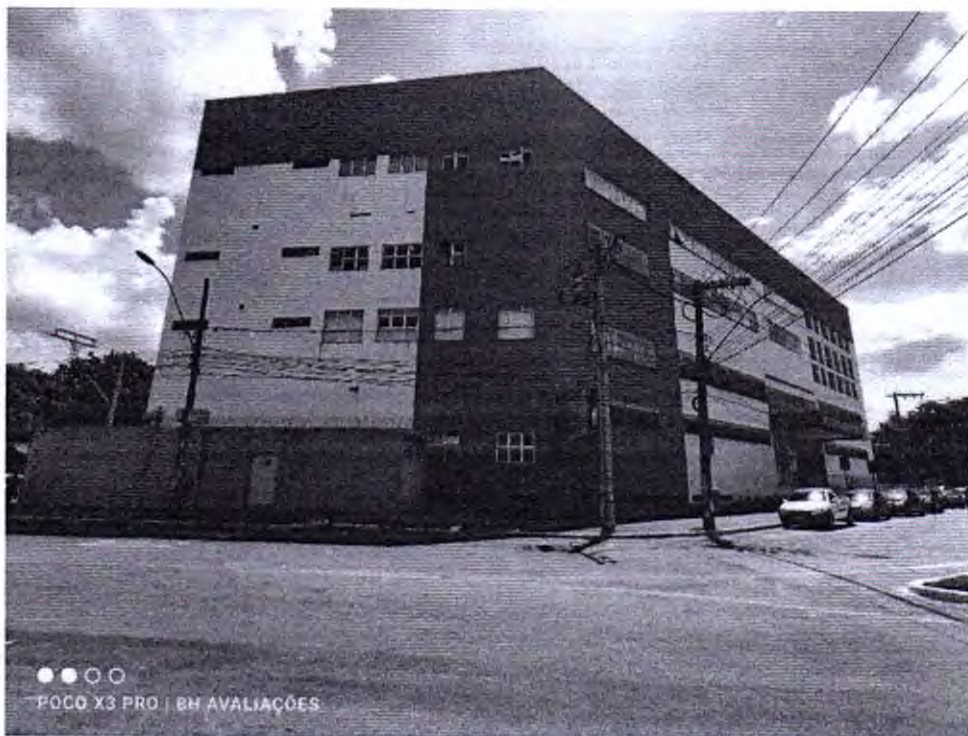
Fachadas voltadas para as Avenidas Simon Bolivar e Carlos Chagas, Bairro Cidade Nobre, Ipatinga/MG.
