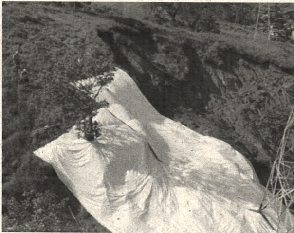
Figura 7 – Equipe Cemig realizando o lonamento da região da estrutura no dia 16/01/2025.
