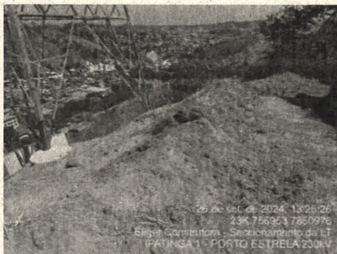
Figura 4 – Banqueta de proteção
