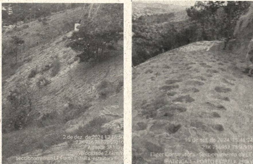
Figura 5 – Abertura de covas e início do plantio de vegetação inicial nas áreas modificadas realizado ao longo de dezembro de 2024, quando ocorre o período chuvoso, favorecendo o sucesso do plantio.
